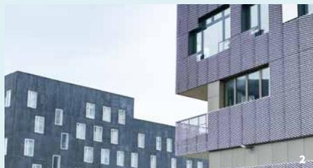
La distribution des ouvertures, en apparence aléatoire, s'accorde aux vibrations visuelles provoquées par les mailles et les reliefs de l'acier. Premier bâtiment universitaire français labellisé BEPOS, bâtiment à énergie positive, il dispose d'une efficacité énergétique exceptionnelle, et bénéficie également du label Haute qualité environnementale (HQE) Bâtiments tertiaires.
